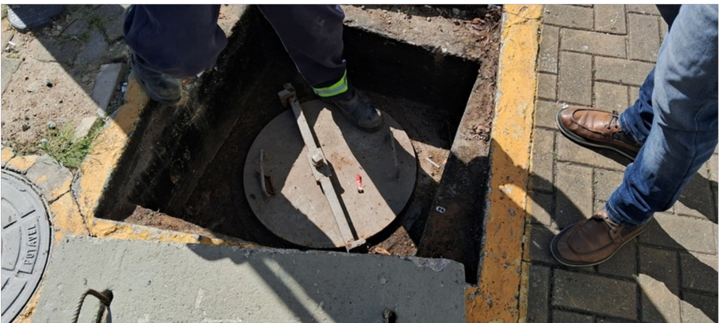
Foto 1 – Tampa de aço do abrigo, com fechamento de trava de ferro
