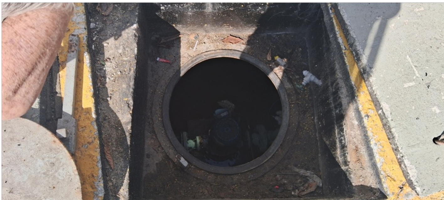
Foto 2 – Caixa de aço (panelão)
