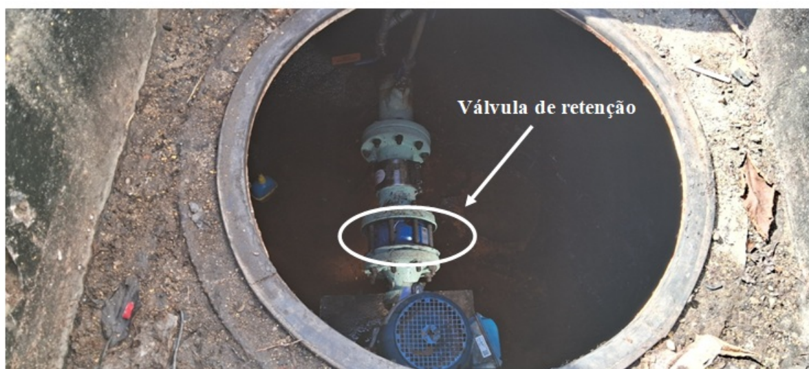
Foto 6 – Bomba do tipo centrífuga in line .
