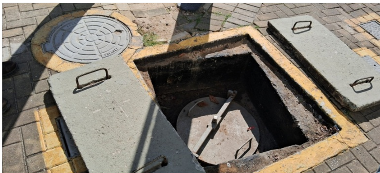
Foto 3 – Tampas (2) de concreto
