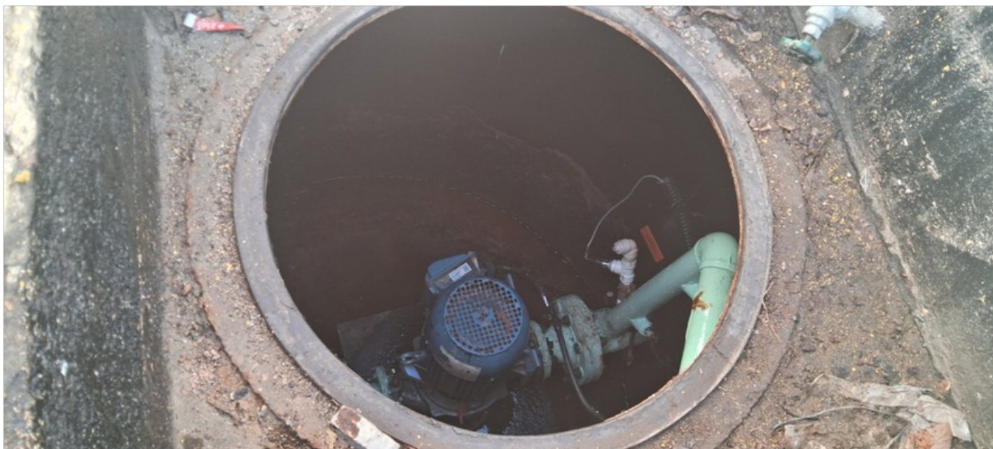
Foto 6 – Bomba do tipo centrífuga in line .
