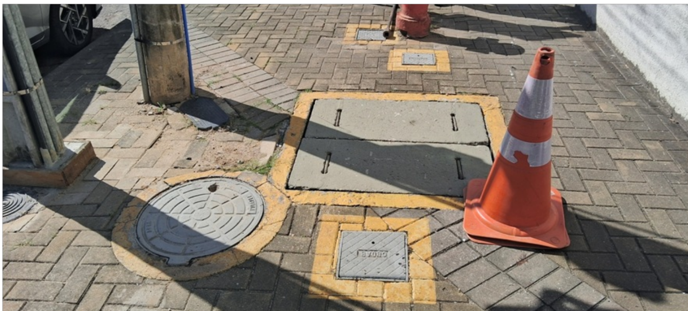
Foto 5 – Sinalização, na cor amarela, no passeio público.
